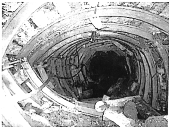
a) Đường lò xuyên vỉa +17 vị trí PK 348 bị nén lún do áp lực bãi thải
