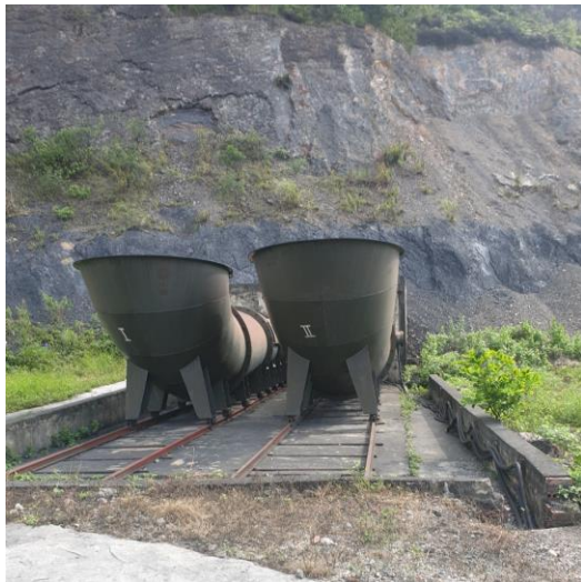
Hình 4. Hình ảnh bên ngoài trạm quạt FBCDZ-N 0 17 mức +25
