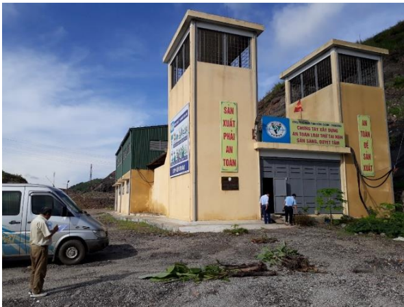
Hình 13. Hình dáng chung của trạm quạt 2K56 - N 0 24 mức +20 khu Cánh Đông và cửa thượng thông gió
