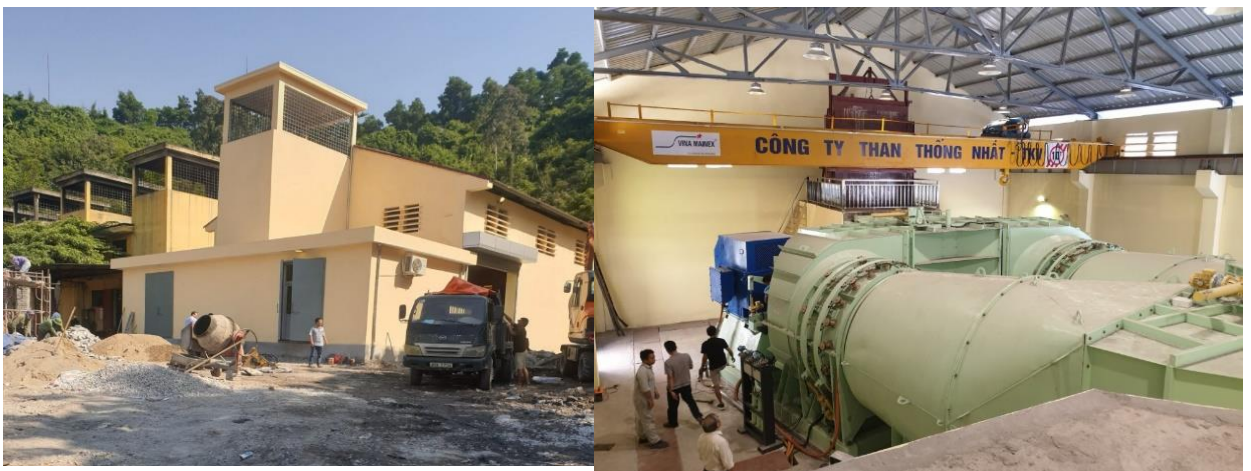
a). Hình dáng chung của nhà che 3 trạm quạt gió chính tại mặt bằng +52
