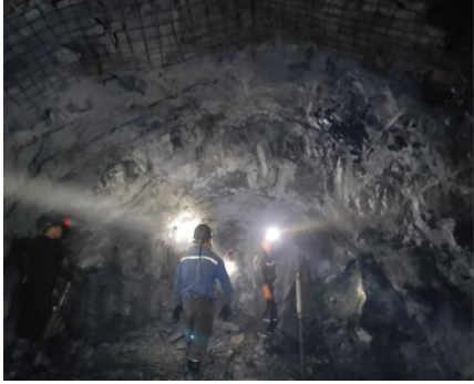
Hình 8. Hình ảnh thi công lò dẫn ngã ba theo phương án lò dẫn cải tiến, sử dụng neo lưới thép và bê tông phun để gia cố.
