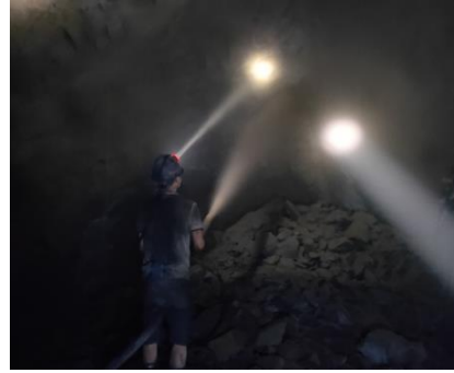
Hình 8. Hình ảnh thi công lò dẫn ngã ba theo phương án lò dẫn cải tiến, sử dụng neo lưới thép và bê tông phun để gia cố.
