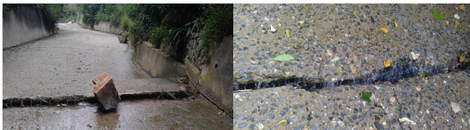
Hình 1. Lòng suối B bị gãy
