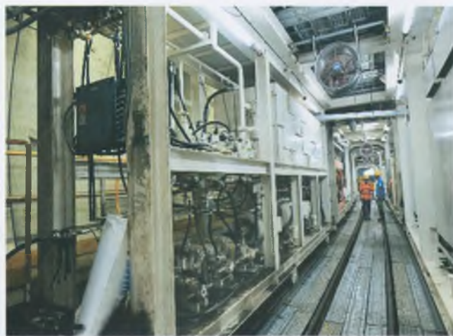
H. 6. Hình ảnh quá trình lắp đặt và thiết bị bên trong Máy khoan đào tuyến số 1 tại Tp. Hồ Chí Minh: a - Quá trình lắp đặt đầu đào; b - Bên trong máy
