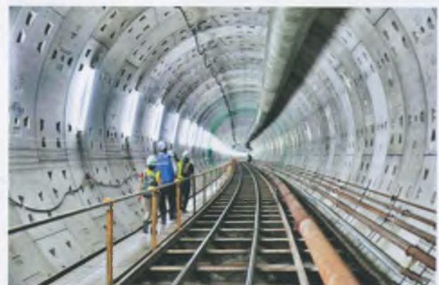
H.7. Hình ảnh đường hầm nối giữa hai ga Ba Son và Ga Nhà Hát lớn tuyến metro số 1 Tp. Hồ Chí Minh sau khi thi công và lắp dựng kết cấu chống.
