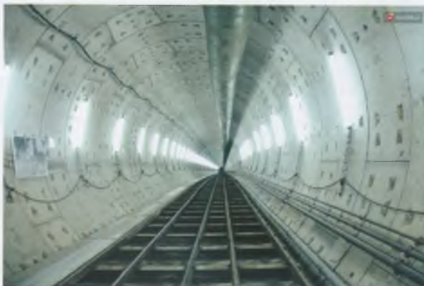
H.7. Hình ảnh đường hầm nối giữa hai ga Ba Son và Ga Nhà Hát lớn tuyến metro số 1 Tp. Hồ Chí Minh sau khi thi công và lắp dựng kết cấu chống.
