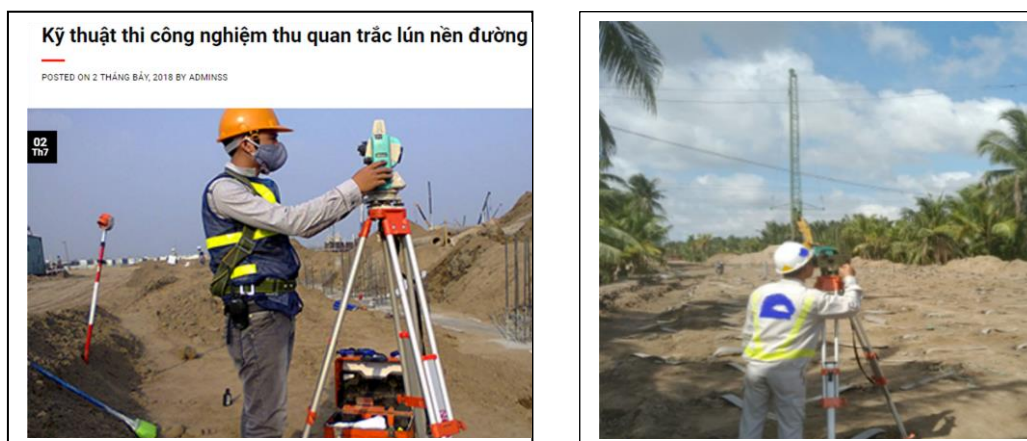
Hình 3. Sử dụng thiết bị không phù hợp để quan trắc độ lún
