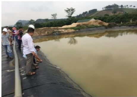
Hình 3. Hồ sinh học trong hệ thống XLNT của Công ty CP Mía đường Sơn La
