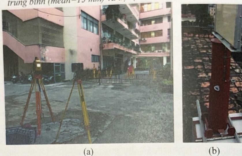
Hình 5. Máy quét Topcon GLS - 2000 (bên trái), máy quét Faro Focus3D X130 (bên phải) (a); Cấu tạo của hệ thống mốc và thanh trượt (b)
