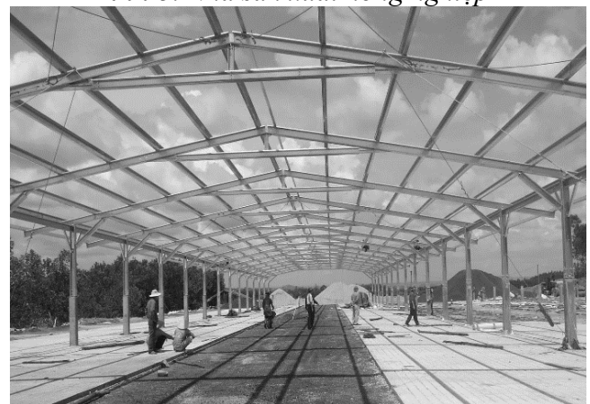
Hình 6. Nhà xưởng nhịp rộng
