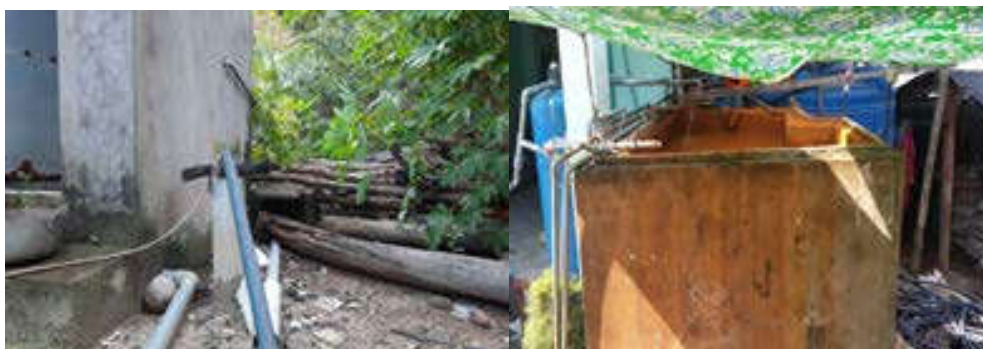
Hình 5: Giếng khoan bị nhiễm phèn tại Hòn Mầu
