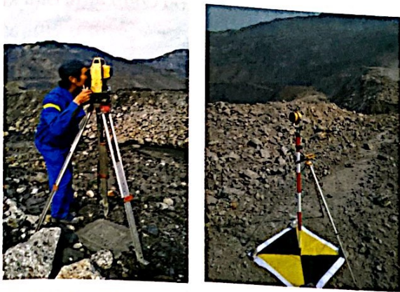
Hình 1. Đo nối tọa độ các điểm khống chế ảnh
