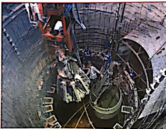
Hình 2. Gấu nhót HZ-6 và thùng trực thi công giếng đứng Hà Lám
