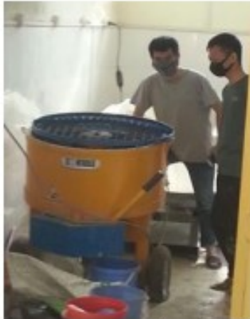
Hình 1. Quá trình tính toán cấp phối và phối trộn các mẫu bê tông xi măng tro bay (BTXMTB)
