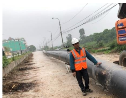
Hình 7. Thi công kéo ống HDD tại Dự án thoát nước thải thành phố Hưng Yên
