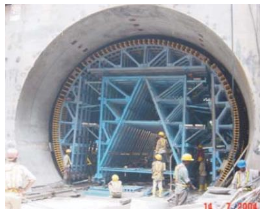
b) Tro bay được sử dụng làm bê tông liên khối tại dự án hầm metro Delhi Metro Rail Corporation ( https://www.ntpc.co.in )
