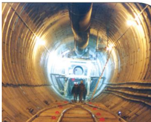
a) Vỏ chống đúc sẵn cho đường hầm xây dựng dưới sông St. Clair giữa Sarnia, Ontario và Port Huron, Michigan, Hoa Kỳ ( http://www.vncold.vn//Content.aspx?distid=839 )
