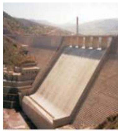
c) Đập Beni Haroun Dam trên sông Elkabir (Ấn Độ) ( https://www.ntpc.co.in )
