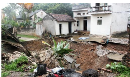
Sụt lún tại xã An Tiến, Mỹ Đức, HN, đường kính 14m, sâu 11,3m
