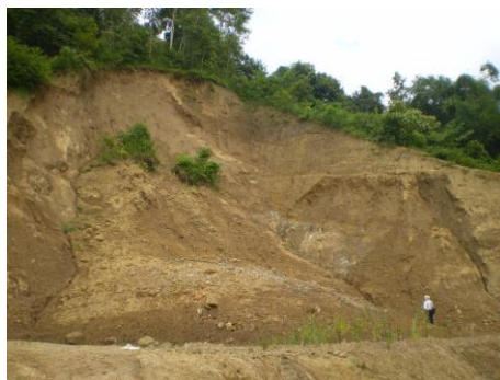
Hình 5. Vỏ phong hóa khá dày trên các đá trầm tích lục nguyên tại khu vực Chợ Đồn (Bắc Kạn), xảy ra trượt xoay
