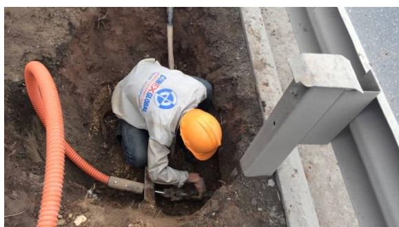
Hình 8. Khoan ngang qua đường tại Phú Thọ
