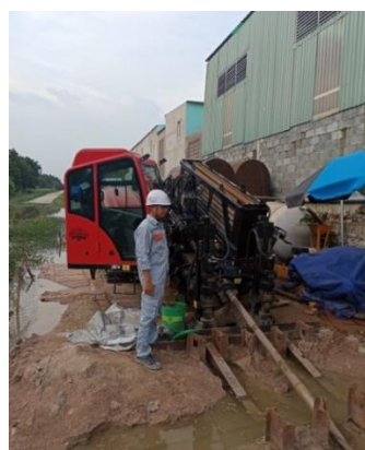
Hình 9. Khoan ngang định hướng tại dự án lắp đặt đường ống dẫn dầu tại Vũng Tàu
