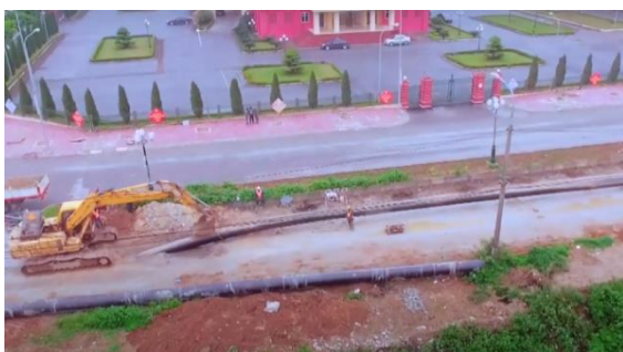
Hình 7. Thi công kéo ống HDD tại Dự án thoát nước thải thành phố Hưng Yên
