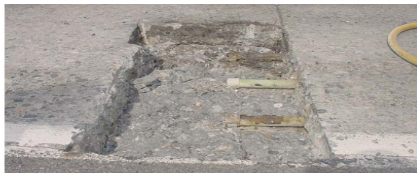
Hình 1: Mặt đường bị hư hại có chốt truyền lực giữa các tấm ri sét [1]
