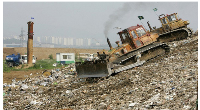
Rác thải được chôn lấp theo từng khu, sau khi khử trùng được vận chuyển, rải, cuộn, phủ đất...
