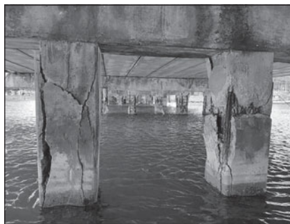
Рис. 1. Повреждение железобетонных гидротехнических конструкций в результате коррозии в морской воде, Вьетнам
