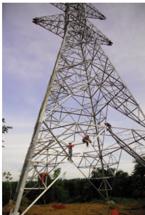
Đội xây lắp 11.1 thi công tuyến 500KV mạch 3 Quảng Bình - Đà Nẵng
