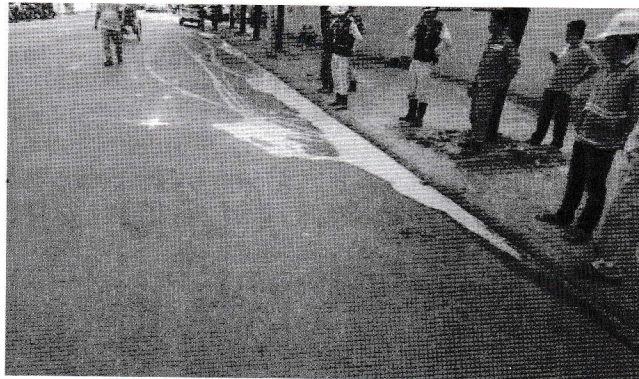
H.5. Dung dịch polymer phun lên trên mặt đường khi xảy ra sự cố đẩy trôi
