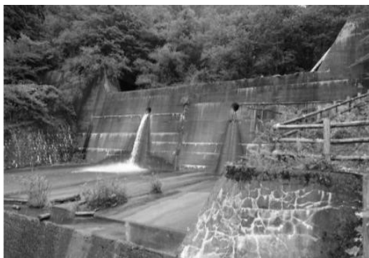
Hình 2. Đập Sabo kín bằng bê tông (a) và bằng rọ đá (b) ở Gifu, Nhật Bản
