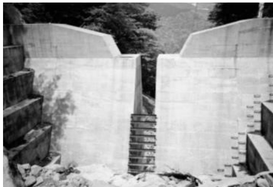
Hình 3. Đập Sabo hở bằng kết cấu thép (a) và đập Sabo với khe hở ở giữa (b) (Mizuyama, 2008)
