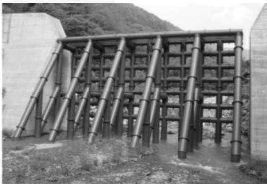
Hình 3. Đập Sabo hở bằng kết cấu thép (a) và đập Sabo với khe hở ở giữa (b) (Mizuyama, 2008)
