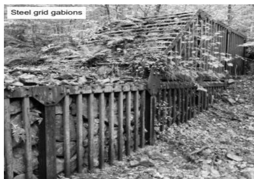
Hình 2. Đập Sabo kín bằng bê tông (a) và bằng rọ đá (b) ở Gifu, Nhật Bản
