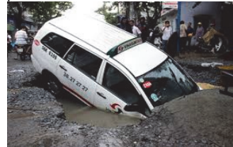
Hình 6. Ngập úng gây sụt lún nền đường Võ Văn Kiệt-Q.8 (6.2015)
