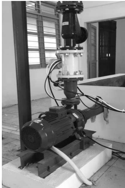
Hình 2. Vị trí lắp đặt các cảm biến lưu lượng và áp suất
