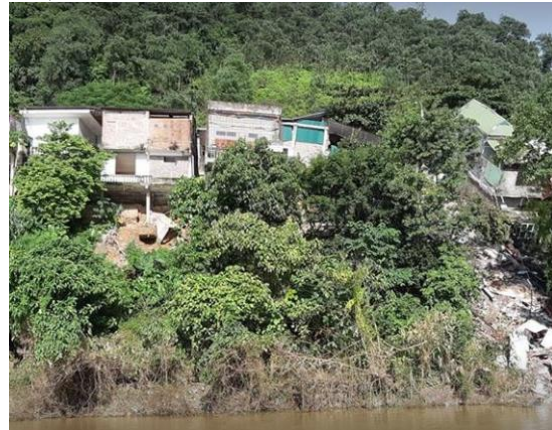
Ảnh 5. Nhà dân được xây dựng trên sườn dốc, đã bị hờ cả chân móng ven theo sông Đà.
