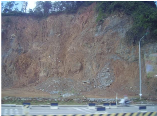
Ảnh 1. VPH hoàn toàn, tạo sét màu nâu vàng, nâu xám trên đá của hệ tầng Sông Bôi, bị bão hòa nước, gây trượt lở.
