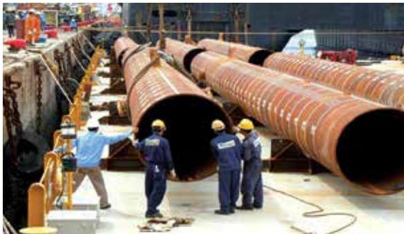
Hình 13. Hạ thủy cọc xuống sà lan vận chuyển
