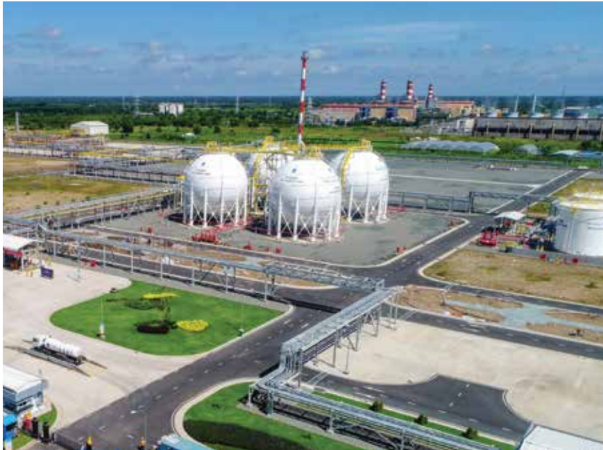
Nhà máy xử lý khí Cà Mau. Ảnh: PV GAS
