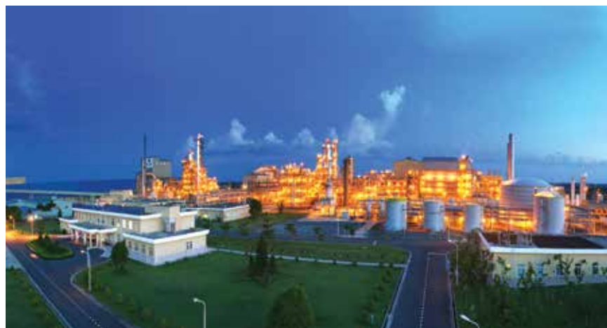
Nhà máy Đạm Cà Mau. Ảnh: PVCFC
