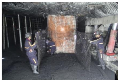
a. Vị trí thi công dải trụ nhân tạo
