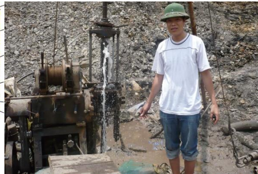
Hình 14. Khoan giảm áp tại bờ trụ mỏ Na Dương
