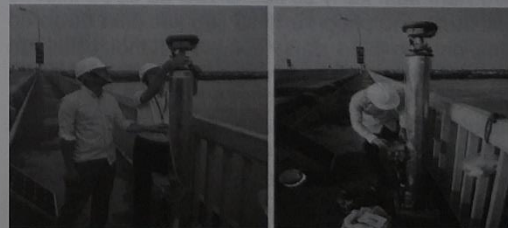
H.7. Lắp đặt thiết bị quan trắc dịch chuyển biến dạng cầu
