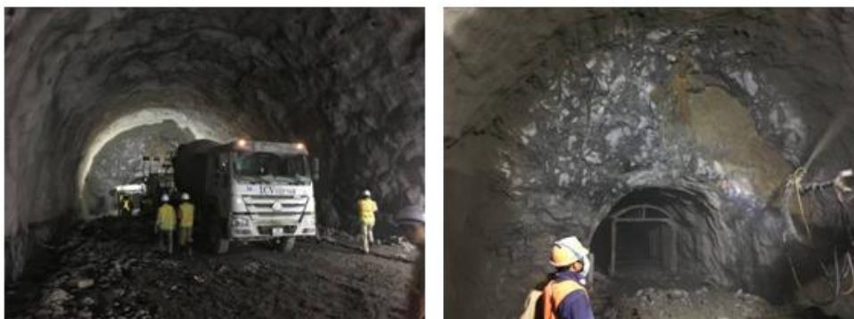
Hình 9. Công tác khoan nổ mìn mở rộng đường hầm phụ dự án hầm Hải Vân
