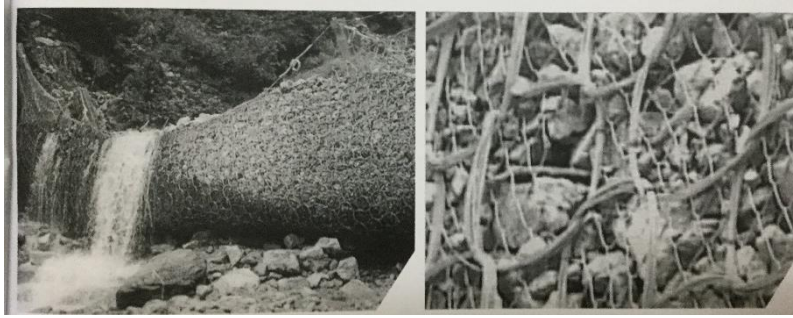
Hình 5. Rào lưới ngăn lũ bùn đá của hãng Geobrugg Thụy sỹ
