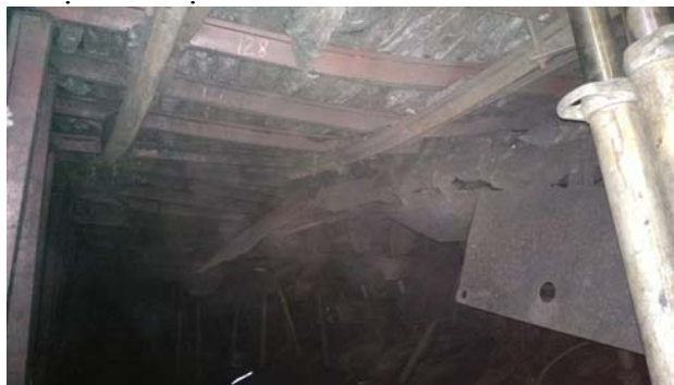
Hình 3. Khâu chống tạo diện xong chuẩn bị thu hồi dàn chống Vinaalta - Công ty than Nam Mẫu
