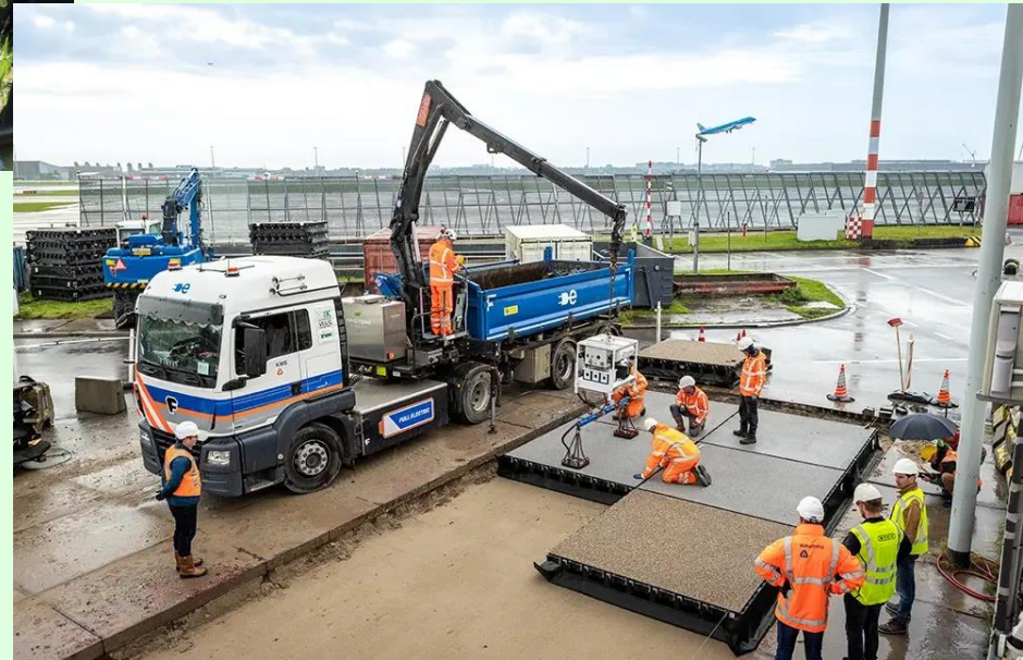
Mặt đường bằng nhựa tái chế
