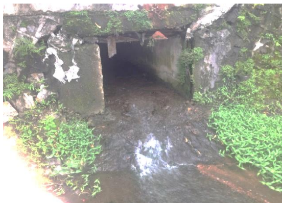
Hình 3.22: Đầu cống thoát nước thải khu 3, phố Sông Uông
