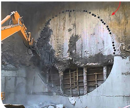
Hình 3. Phá tường vữa bằng khoan rút lõi và búa đục
