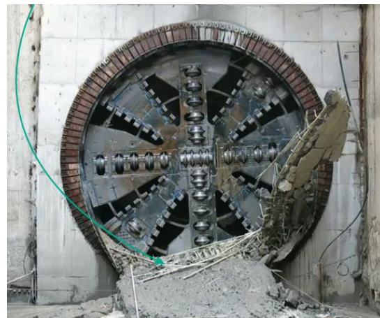
Hình 4. Phá tường vữa bằng đầu cắt TBM
