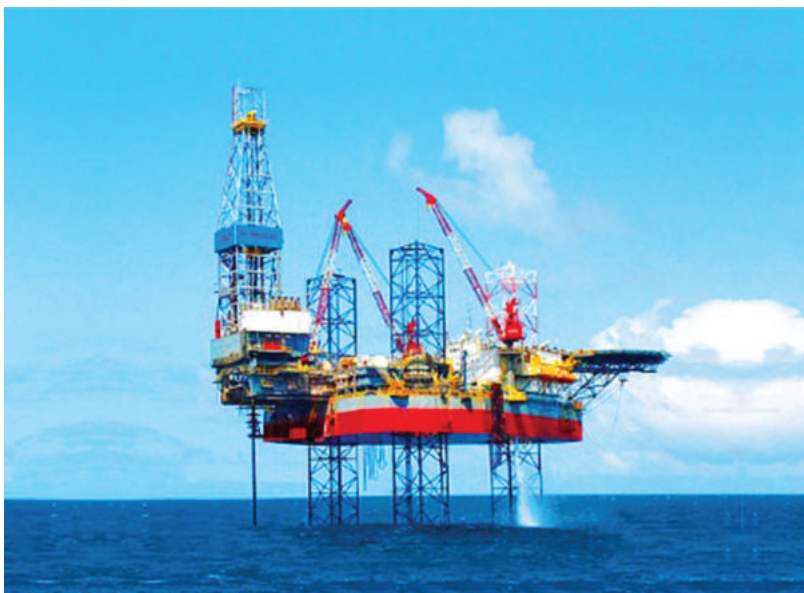
Giàn khoan biển tự nâng PV DRILLING I
