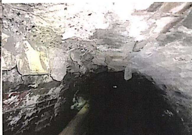
Phá hủy vỏ bê tông lưu vì tai đường lò 17.2 do ảnh hưởng của nước chảy từ bãi thải
