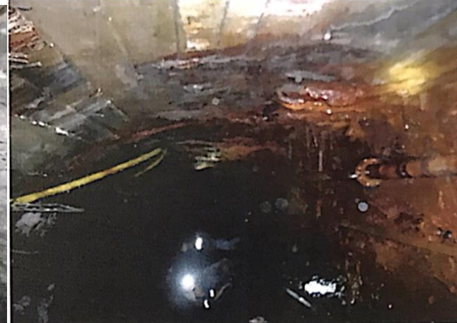
Phá hủy vỏ bê tông lưu vì tai đường lò 17.2 do ảnh hưởng của nước chảy từ bãi thải
