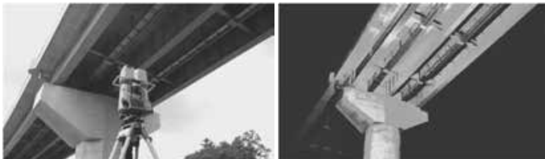
Hình 4. Quan trắc, kiểm định công trình cầu
