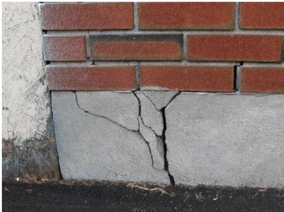
Рисунок 1 - Отказ фундамента, выраженный раскрытием трещин
