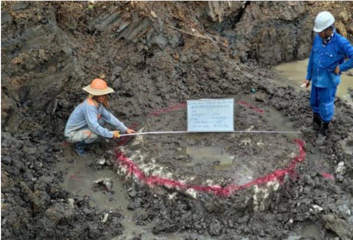
Hình 7. Đầu cọc sau khi thi công.
