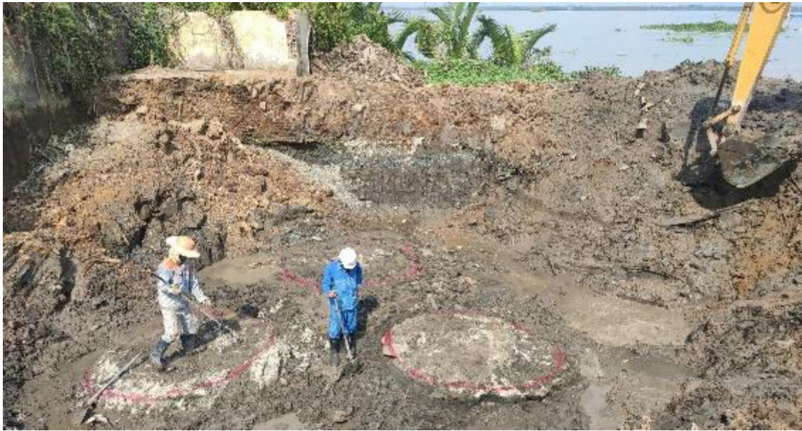
Hình 5. Đào lộ đầu cọc.
