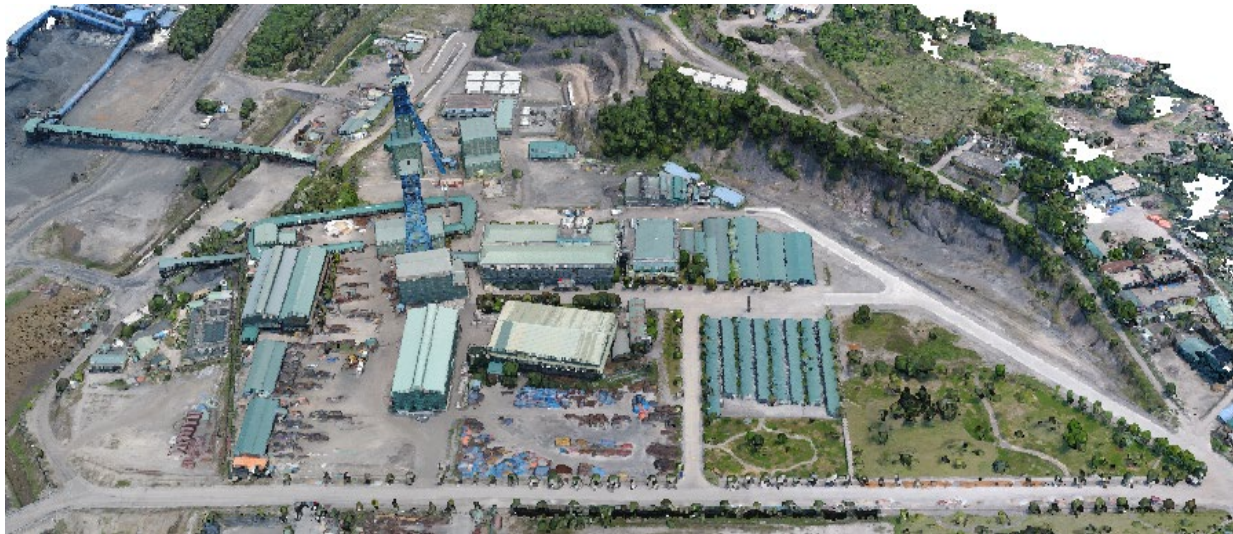
Hình 6. Đám mây điểm 3D tại khu vực SCN35 thành lập từ ảnh bay chụp UAV.
