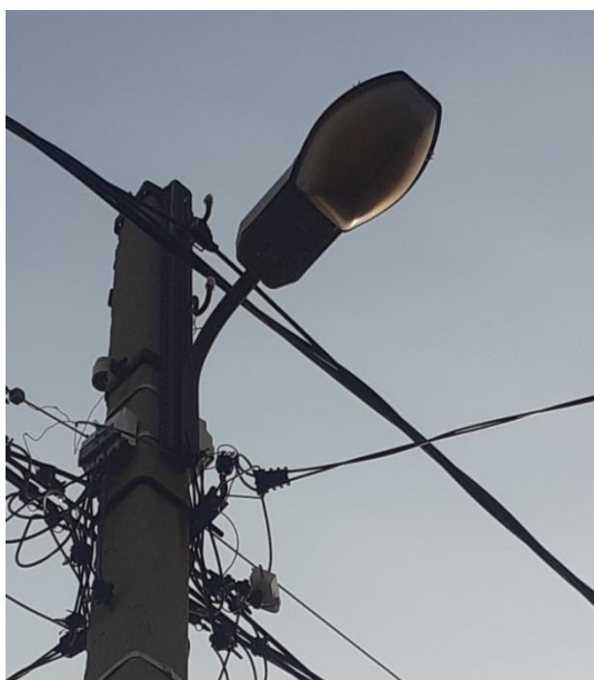
Рисунок 3 – Осветительные приборы, вышедшие из строя (а) и с загрязнением осветительной поверхности (б)
