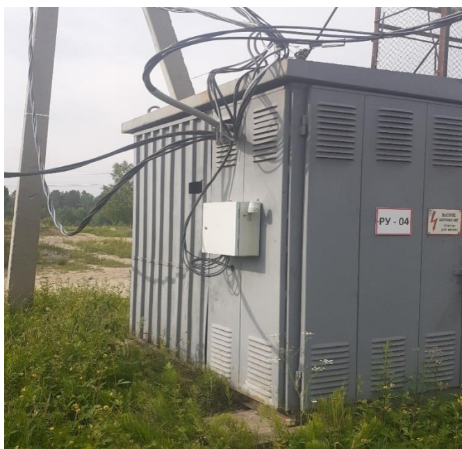
Рисунок 2 – Типовое размещение щита управления наружным освещением
