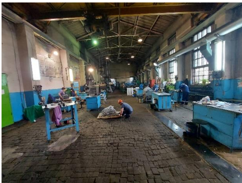
Рисунок 4 – Изоляционный участок восстановления изоляции электрических машин
