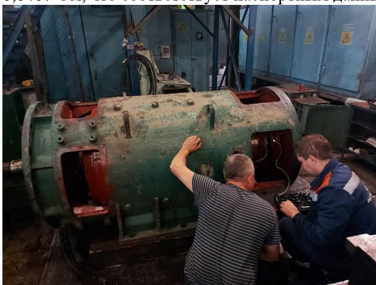
Рисунок 5 – Выполнение ремонтно-профилактических работ на двигателе МПС-640-700
