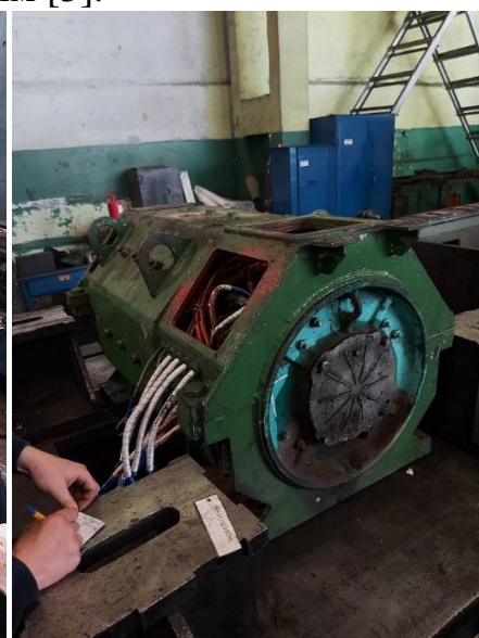
Рисунок 6 – Выполнение ремонтно-профилактических работ на двигателе ДЭ-816
