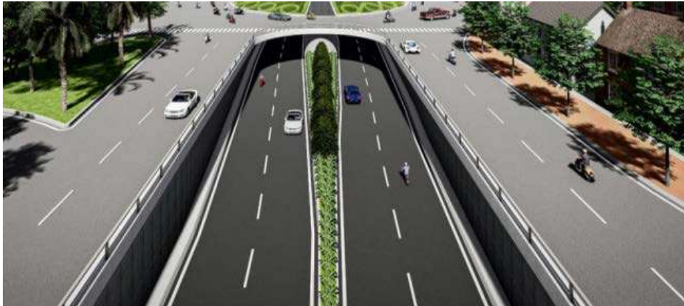
Hình 4. Phương án sử dụng hầm ngầm trên đường 3 tháng 2, thành phố Vũng Tàu tại nút giao thông đang nghiên cứu [1]
