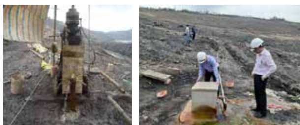
H.8. Thi công và vận hành hệ thống lỗ khoan giảm áp lực bờ trụ
