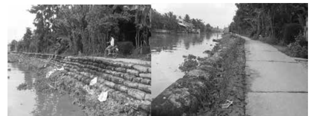
Hình 5. Bờ kè mềm BST Kè chống sạt lở kênh Mỹ Hạnh Bắc, Cái Bè, tỉnh Tiền Giang
