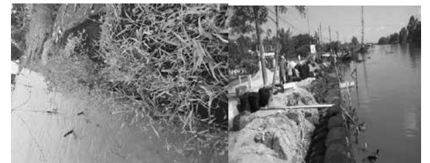
Hình 4. Bờ kè mềm BST sông Cái Tàu U Minh, Cà Mau
