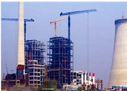
a) Xây nhà máy nhiệt điện.
