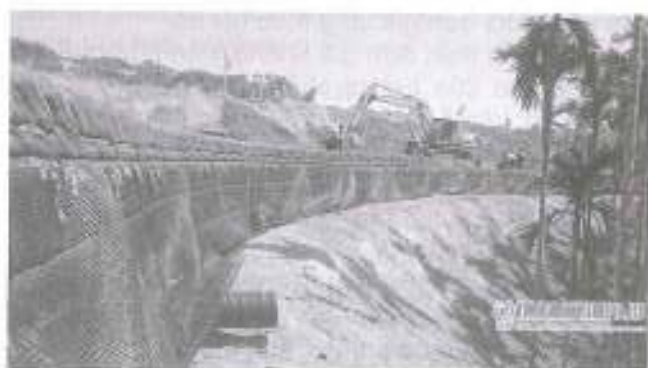
H.4. Đóng và xếp bao tải đất và điều chỉnh mặt bằng
