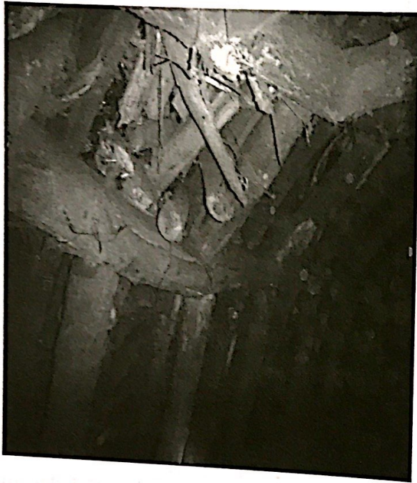
Hình 2.2. Những biểu hiện mất ổn định giải pháp chống gia cường lò dọc vỉa -103
