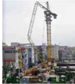
b) cần cẩu tháp bị gãy.
