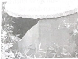
▲ Hình 9. Hố thu gom bao gói TBVTV có nắp đậy không đủ che mưa tại huyện Chợ Mới, tỉnh Bắc Kạn
